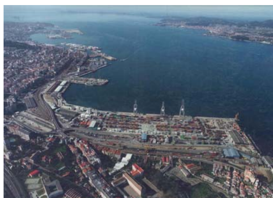
fig.12: El relleno de Guixar en primer plano
