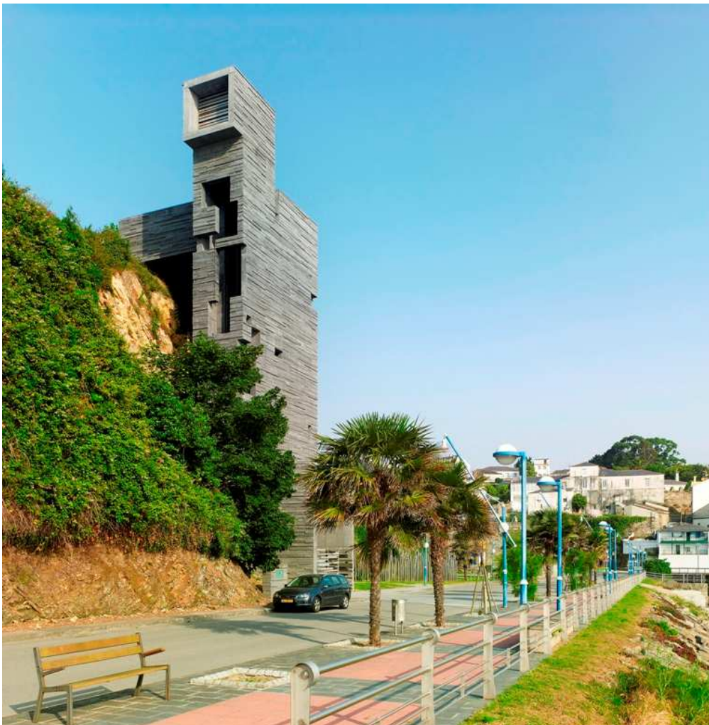
Figura 10: vista inferior desde el puerto comercial
